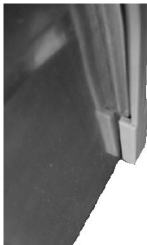
Richtig angesetzte Führungsleiste am Gehäuse
